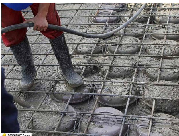
بتن ریزی سقف کوبیاکس
