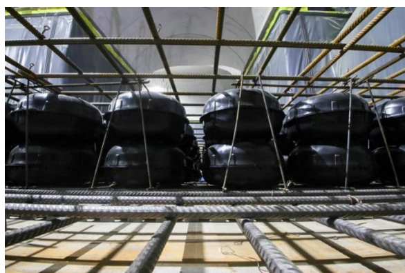
اجرای مش فوقانی
