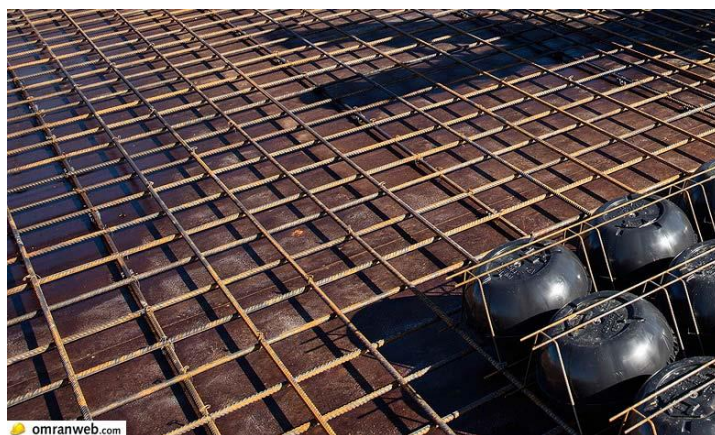
اجرای مش تحتانی
