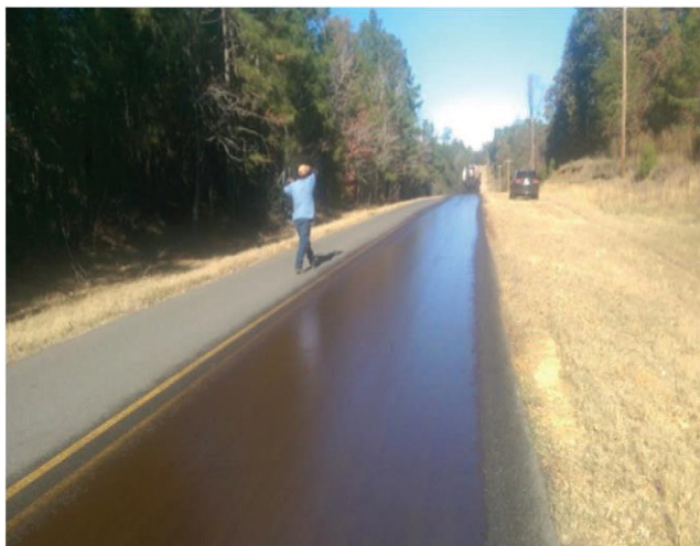
شکل ۲: اجرای فوگ سیل در سطح روسازی
