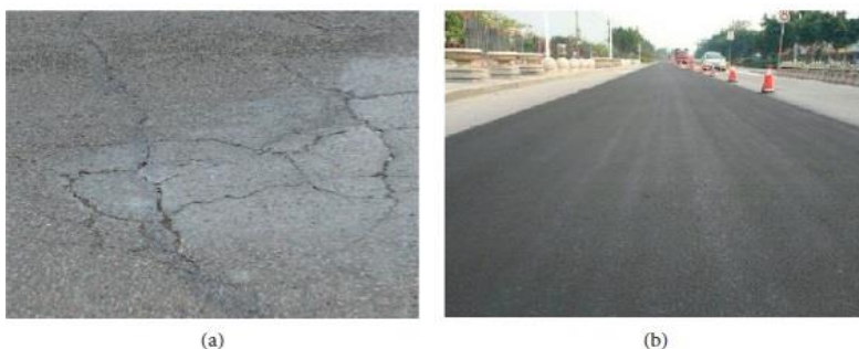
شکل ۱: قسمت a قبل از اجرای فوگ سیل و قسمت b بعد از اجرای فوگ سیل
