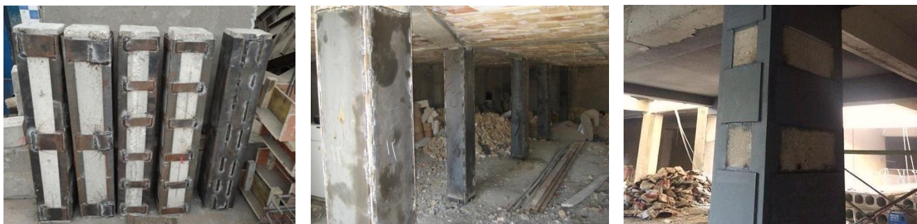
تصویر ۲ انواع روش های مقاوم سازی ستون بتنی با ورق فولادی [۴]
