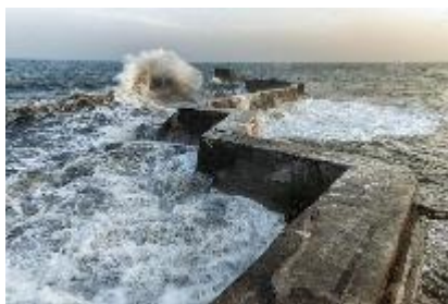
ب) کاربرد بتن سنگین در دیوار موج شکن
