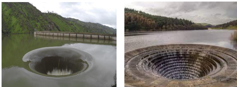
شکل ۱۶. سرریز نیلوفری یا لاله ای [۲۴،۲۱]
