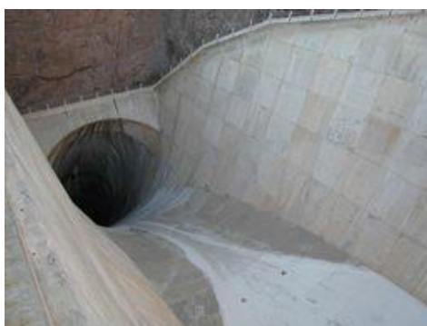
شکل ۱۱. سرریز تونلی [۱۳]
