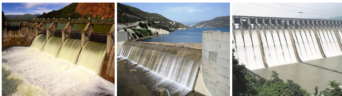
شکل ۱. انواع سرریز [۳،۲،۱]
