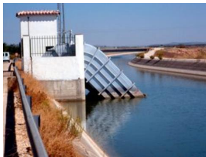
شکل ۷. اجزا یک سرریز سیفونی [۸]
