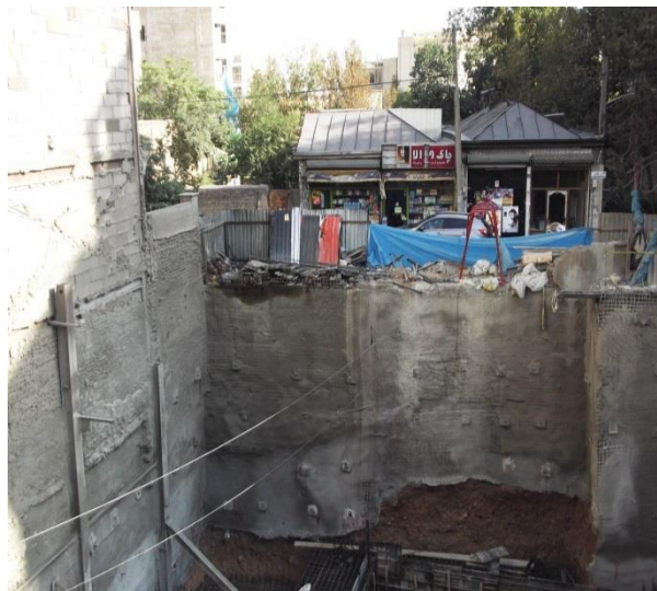
شکل ۲: گودبرداری و پایدارسازی موقت گود در بلوار اندرزگو
