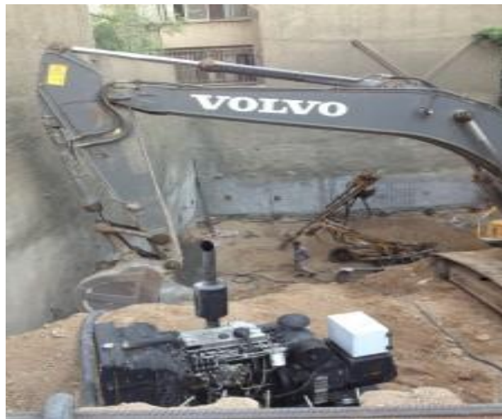
شکل ۱: خاک برداری و پایدارسازی گود واقع در خیابان وزرا به روش نیلینگ و شمع نگهدارنده (Soldier Piles) در تهران، خیابان وزرا، خیابان ششم، انتهای بن بست صادق
