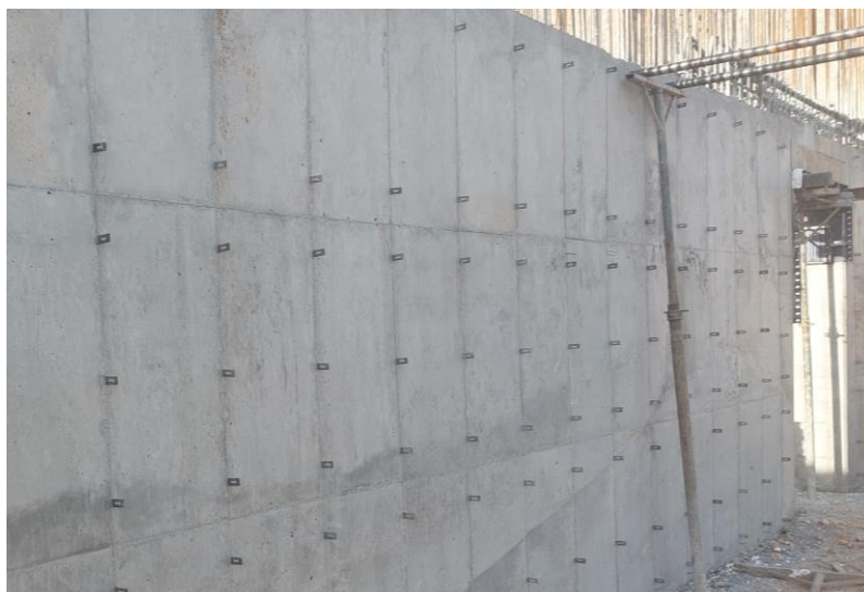
شکل ۲: نمایی از دیوار برشی بتنی با بازشو
