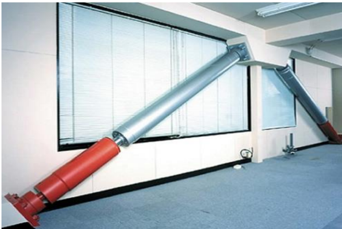
شکل ۳ استفاده از میراگر ویسکوز در یک ساختمان
